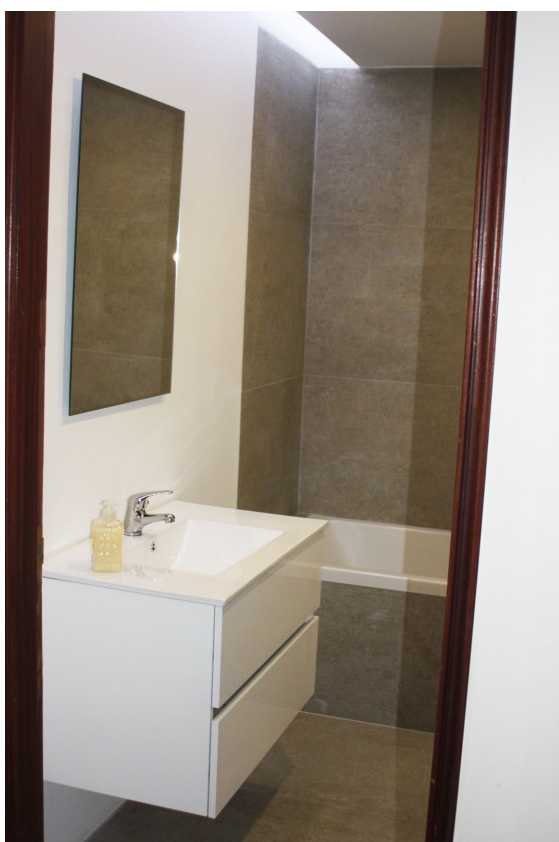
Figura 3 e 4 , Instalação Sanitárias
