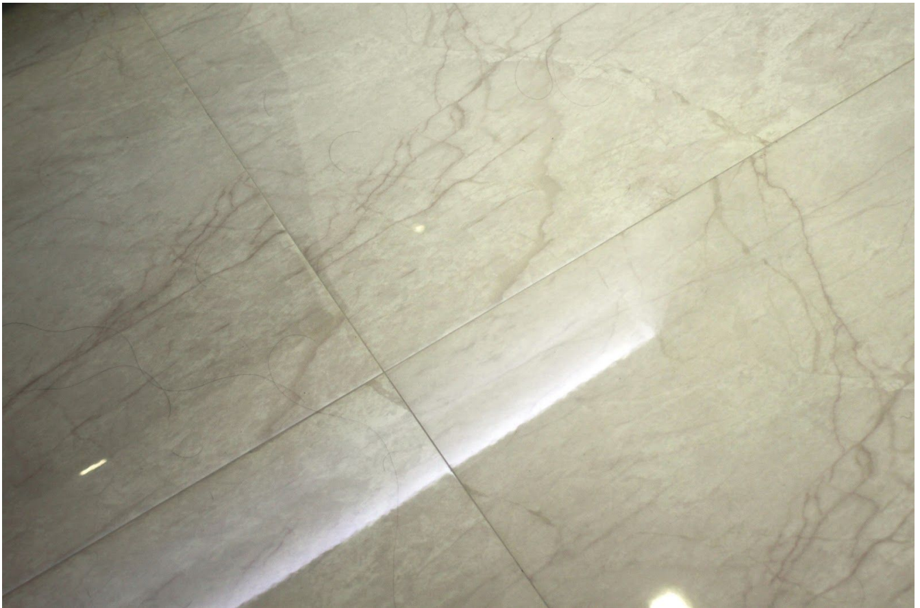
Figura 5, Pormenor de colocação de Mosaico Ceramico, com um perfeito alinhamento de juntas
