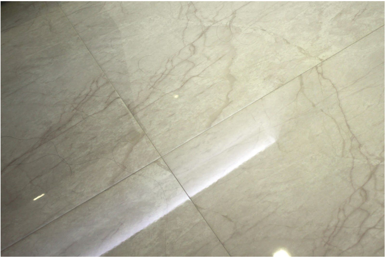
Figura 5, Pormenor de colocação de Mosaico Cerâmico, com um perfeito alinhamento de juntas
