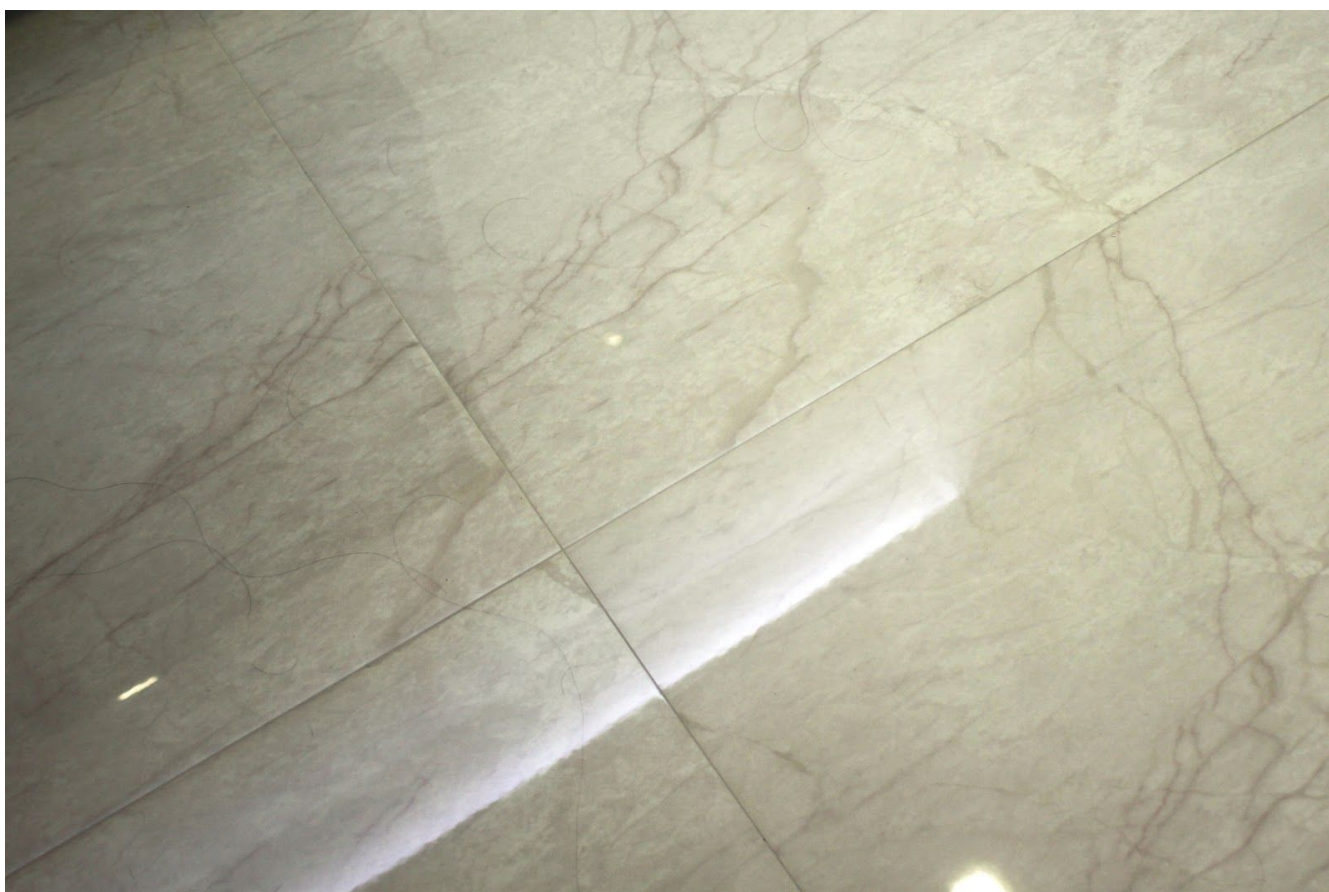
Figura 2, Pormenor de colocação de Mosaico Ceramico, com um perfeito alinhamento de juntas
