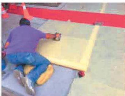
Impermeabilização com Revestech Odivelas
