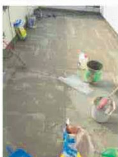
Impermeabilização cimentícia – Oeiras
