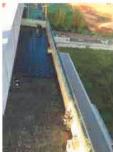
Impermeabilização c/ telas - Odivelas
