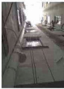
Prumada esgoto Lisboa - Alameda
