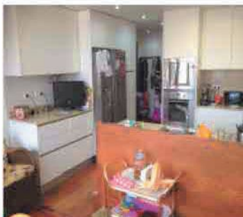
Remodelação total cozinha Portela de Sacavém
