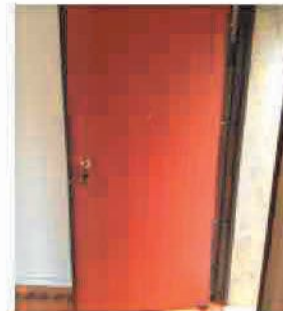
Substituição porta entrada Lisboa - Campo Ourique
