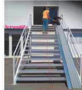
Colocação escadas Alfragide
