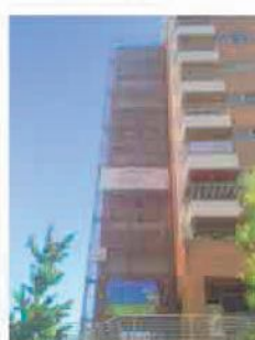
Reabilitação fachadas Alta Lisboa
