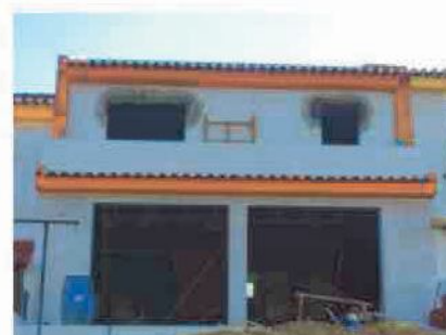
Substituição caixilharia PVC Bobadela
