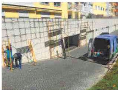
Hidrofugação pedra Lisboa - Expo
