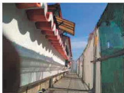
Substituição beirados e telhado Lisboa - Baixa
