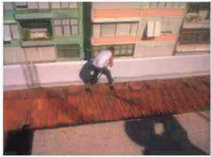
Reparação de cobertura Lisboa – Av. Brasil
