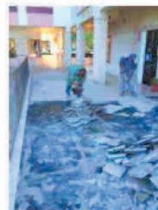
Subst. pavimento Carnaxide
