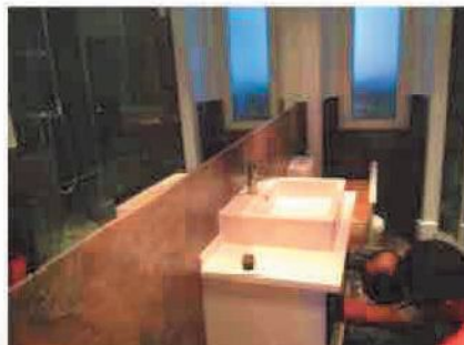
Remodelação WC Lisboa - Calçada Sto. António
