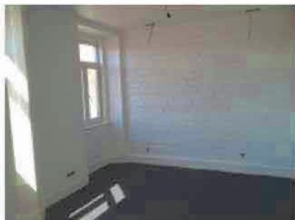
Remodelação completa Lisboa – Calçada Sto. António
