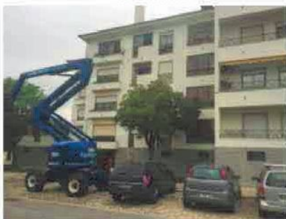
Pintura com máquina elevatória Carcavelos
