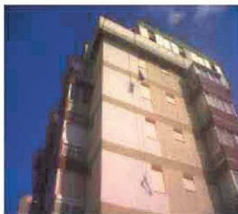
Pintura fachada por rapel Costa Caparica
