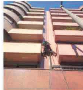
Juntas dilatação Estrada Luz
