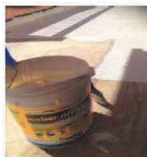
Impermeabilização Estrada da Luz
