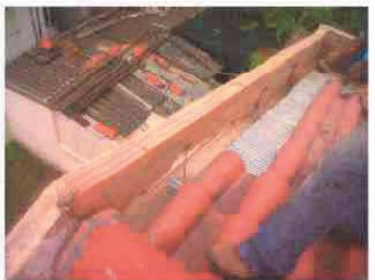
Reparação de cobertura Lisboa - Monsanto
