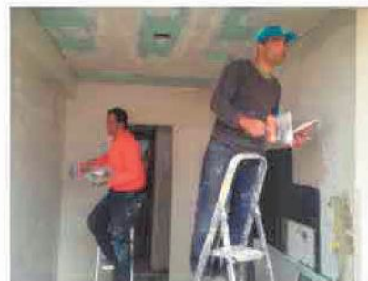
Colocação tecto falso Lisboa - Benfica
