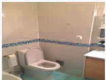
Remodelação WC Lisboa - Alcântara
