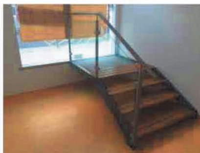
Colocação escadas Lisboa - Av. Roma
