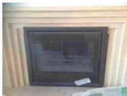
Colocação recuperador Calor Almada - Lazareim
