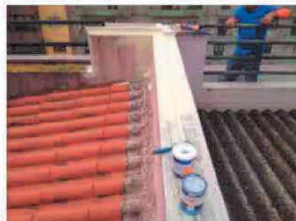
Reparações rápidas Lisboa - Estrada da Luz
