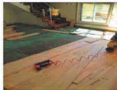
Substituição pavimento madeira Lisboa - Príncipe Real
