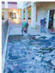
Subst. pavimento Carnaxide
