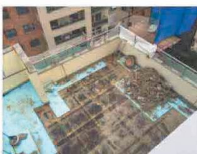
Substituição isolamento térmico Odivelas
