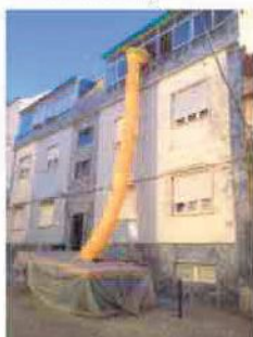
Retirada de entulhos Lisboa - Ajuda
