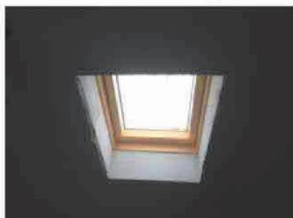
Substituição janelas sótão Lisboa - Praça Espanha
