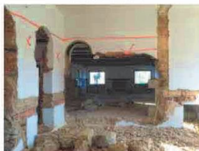
Demolições interiores Cascais - Birre
