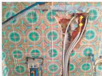
Instalação gás Lisboa - Alcântara
