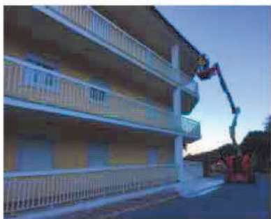
Pintura com máquina elevatória Ericeira
